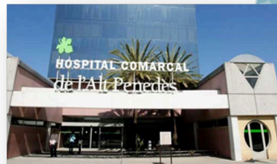
Hospital Comarcal de l'Alt Penedès
