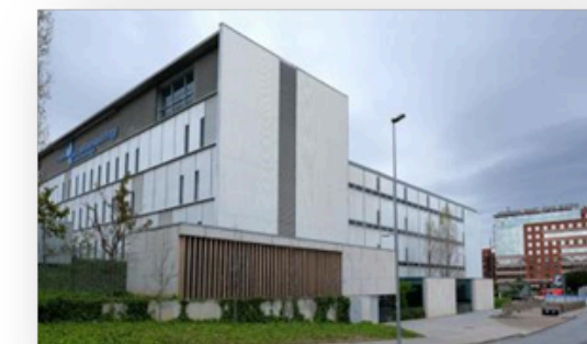
Hospital Moisès Broggi
