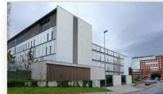
Hospital Moisès Broggi
