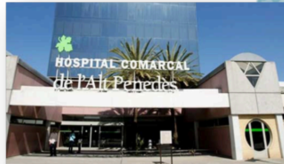
Hospital Comarcal de l'Alt Penedès
